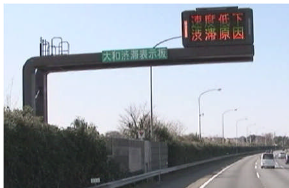
LED標識による速度低下抑制対策(常設化)
