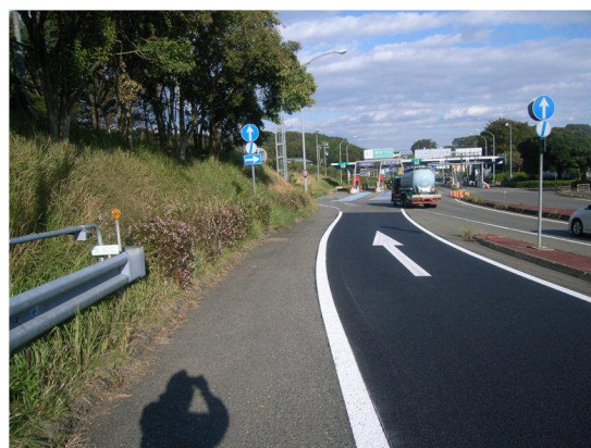
《舗装補修(施工後)》
