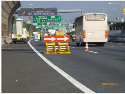
<東名集中工事の規制状況>
