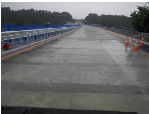
《補修事例(床版取替)》
