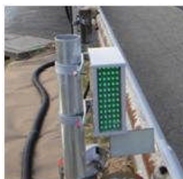
灯具設置状況写真
