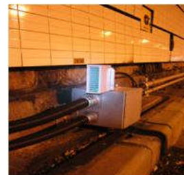
トンネル部灯具写真
