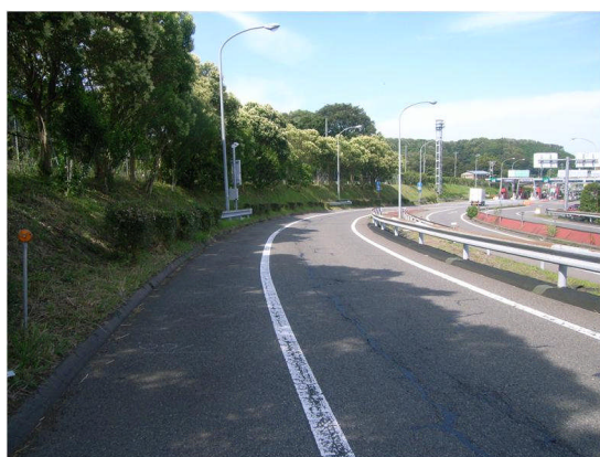
《舗装補修(施工前)》
