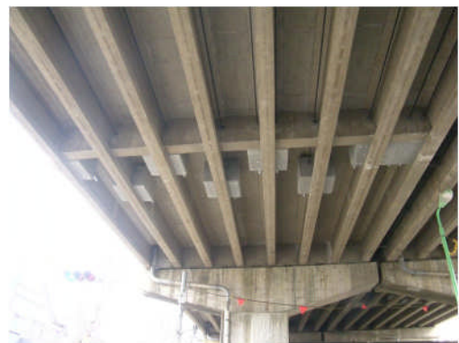
《補修事例(アウトケーブル補強)》
