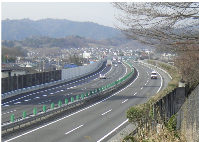
中央自動車道下り線元八王子BS付加車線の運用
