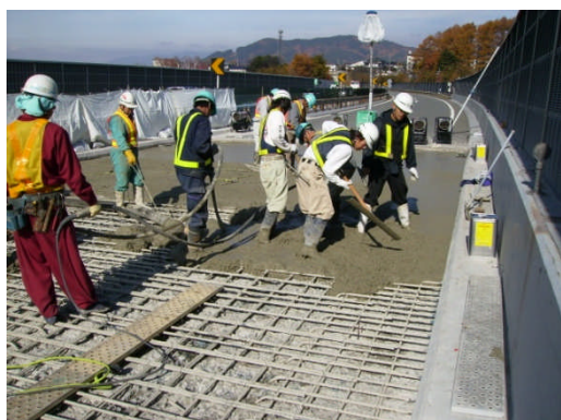
《補修事例（取翻川橋（下）床版取替）》
