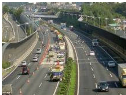
<東名集中工事の規制状況>
