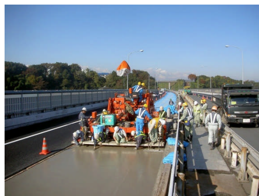
《補修事例（床版増厚）》
