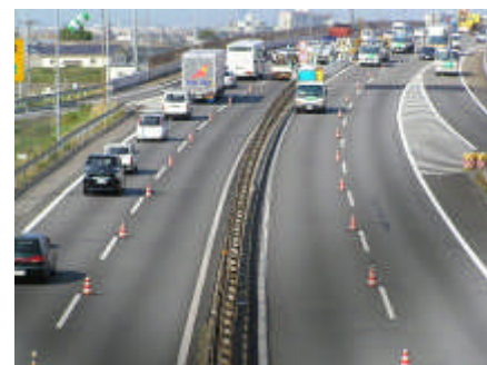
<東名阪リフレッシュ工事の規制状況>
