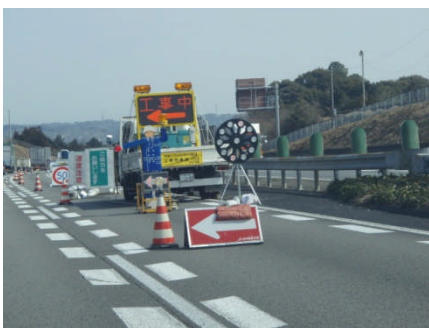
<名神集中工事の規制状況>
