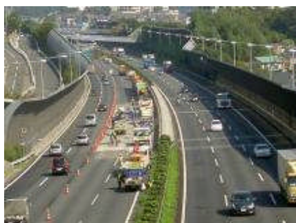
<東名集中工事の規制状況>
