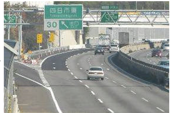
施工後(上り 四日市東インター)
