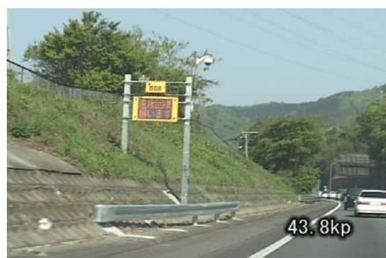
東名 岡崎インターチェンジ付近に設置したLED速度回復情報板
