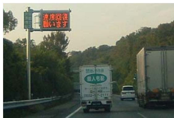
東名 岡崎インターチェンジ付近に設置したLED速度回復情報板
