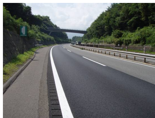
《舗装補修(施工後)》
