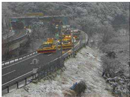
凍結防止剤散布作業状況 (名神高速道路395.3KP付近)
