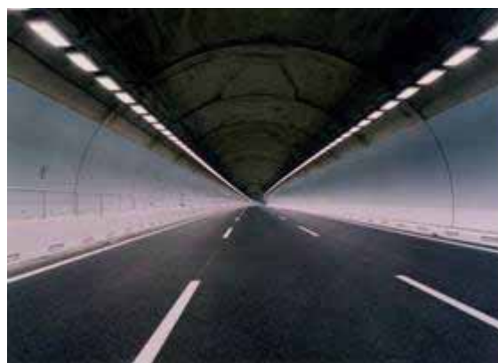
《蛍光灯照明の状況》
