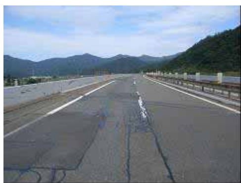
（舗装補修（施工前））
