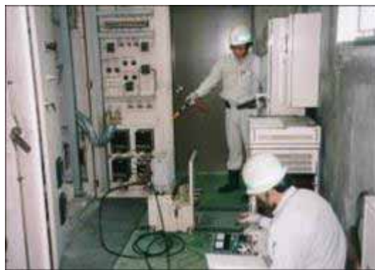
《施設設備点検》
