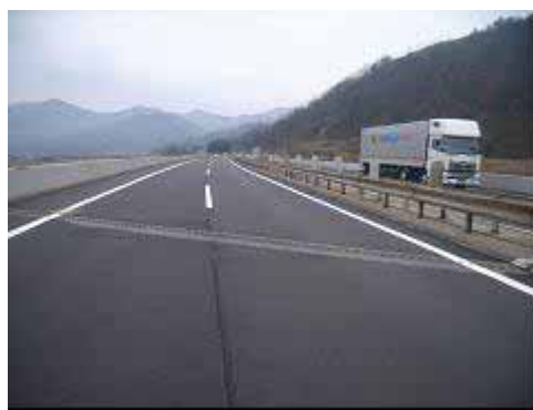
（舗装補修（施工後））
