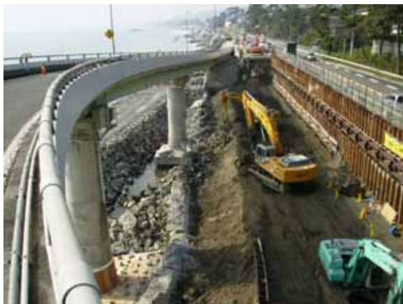
（2車線通行帯確保状況）
