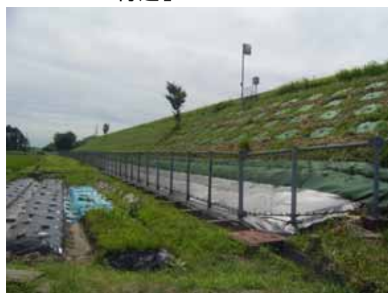
《樹林化（施工後）》
