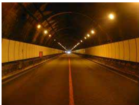
《ナトリウム灯照明の状況》
