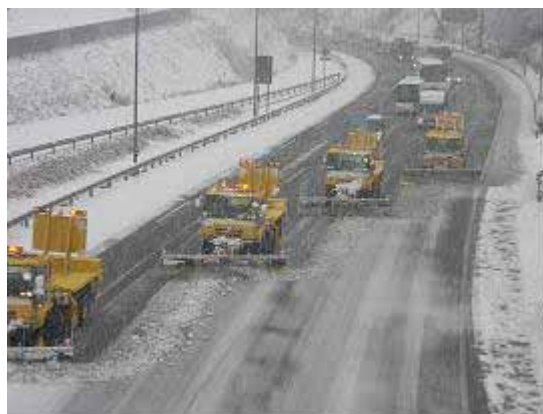
除雪作業状況 (東名高速道路78KP付近)
