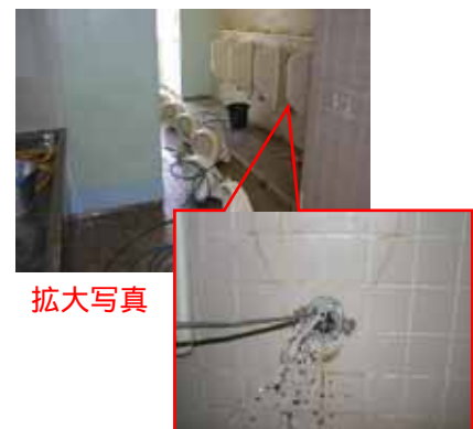
便器を取り外し 排水管の洗浄
