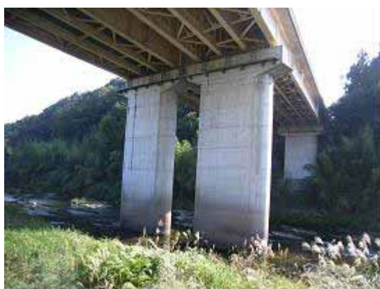
《橋脚補強(施工前)》
