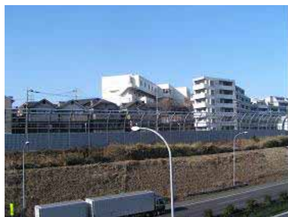
《遮音壁（施工後）》
