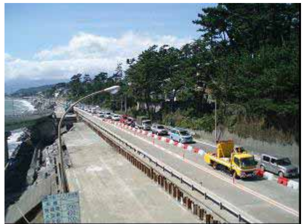
（1車線交通確保状況）
