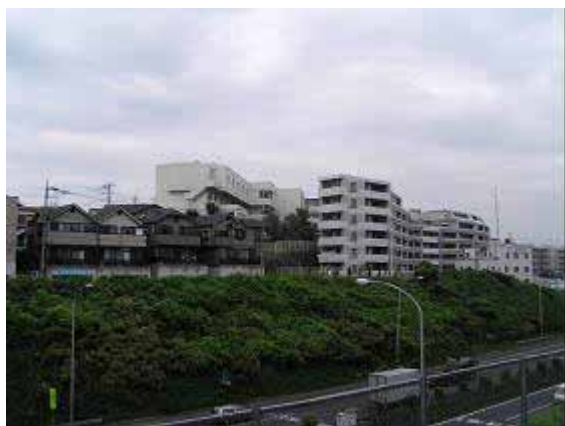
《遮音壁（施工前）》
