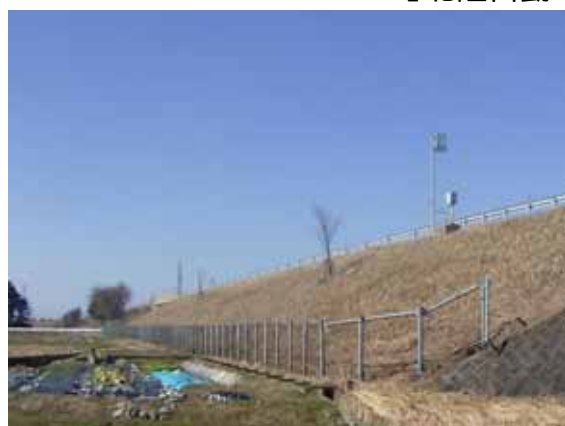
《樹林化（施工前）》
