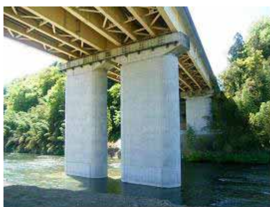
《橋脚補強(施工後)》
