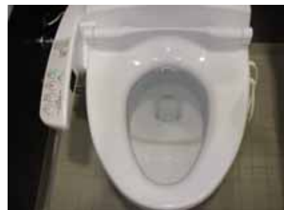
大便器の洋式化及び 洗浄器付便座
