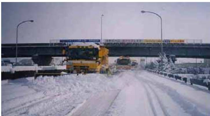
写真. 高速道路における除雪作業
