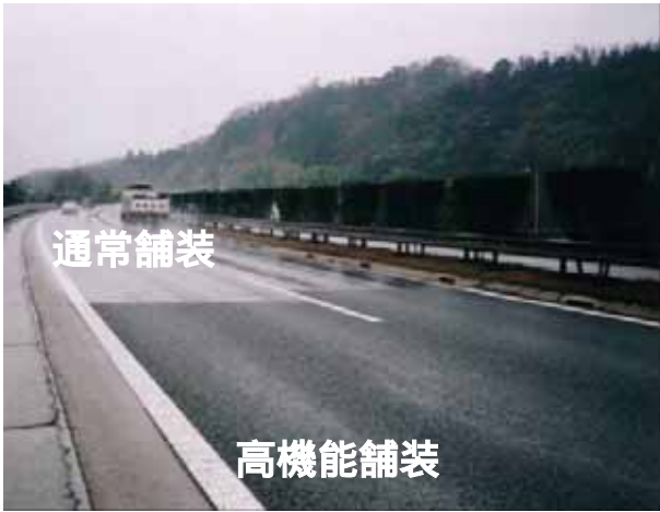
写真・高機能舗装の施工事例
