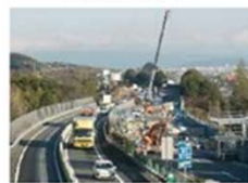
写真1 工事状況(床版取替)
