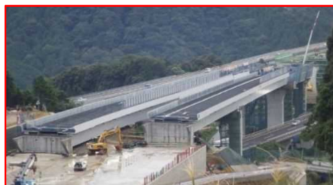
安坂山高架橋
