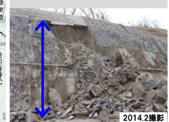
切土のり面の崩落状況
