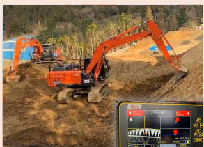
ICT施工の推進
