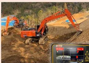
ICT施工の推進
