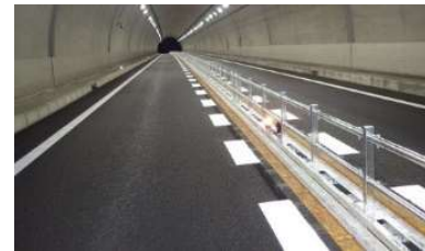
取組み例（センターパイプ・センターブロックの設置）
