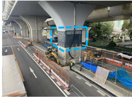
取組み例（炭素繊維巻き立て）
