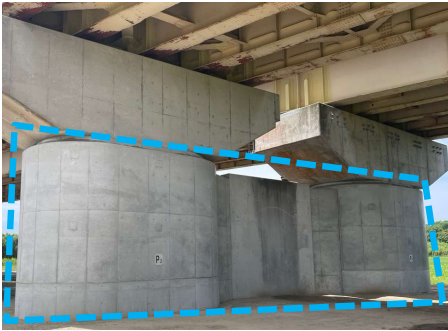
取組み例（コンクリート巻き立て）
