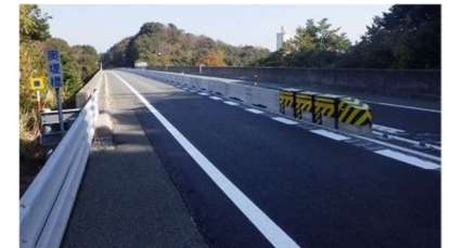
取組み例（センターパイプ・センターブロックの設置）
