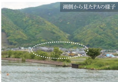
湖側から見たPAの様子
