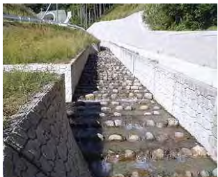
代替えの水路の様子
