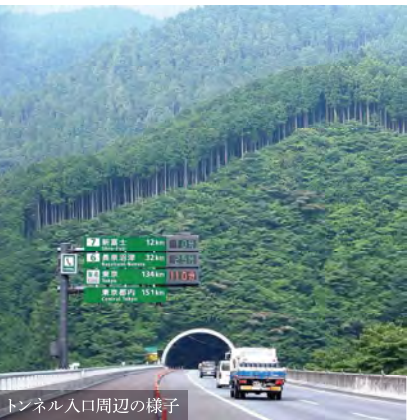
トンネル入口周辺の様子
