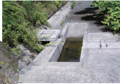
のり面に設置した水飲み場
