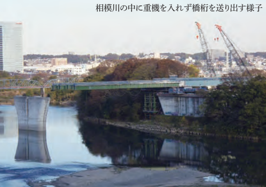
相模川の中に重機を入れず橋桁を送り出す様子
