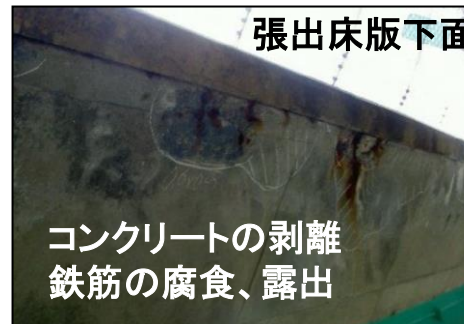
コンクリートの剥離 鉄筋の腐食、露出
