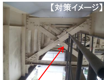
増設した対傾構
