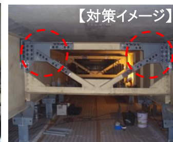
補強部材の取り付け
