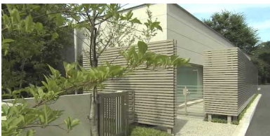
(車両室の外観)
