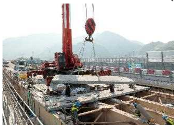
(老朽化した床版を切断し、撤去)
