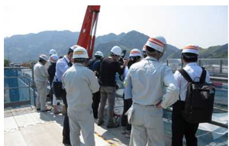
(用宗高架橋の現場公開)
