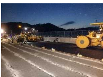
(アスファルト舗装を施工)
