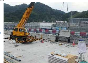
(プレキャスト壁高欄を設置(追越車線側))
