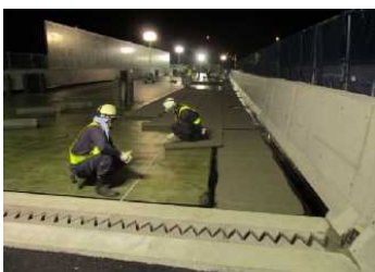
(高性能床版防水工を施工)
