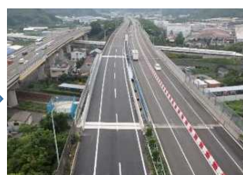
(床版取替え工事完成)
