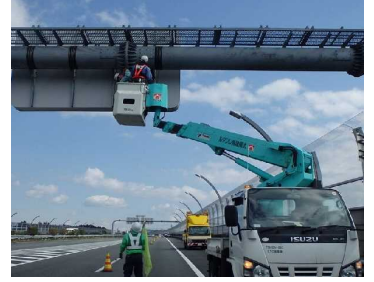
《 門型標識における点検実施状況 》
