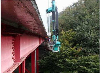
《 橋梁における点検実施状況 》
