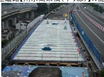
(プレキャストPC床版を設置)
