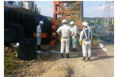
(橋梁架設現場で架台の安定性を確認)
