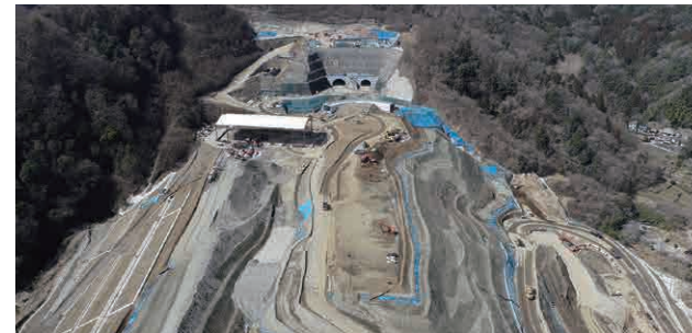
高速道路の建設工事で発生する建設発生土(例)
