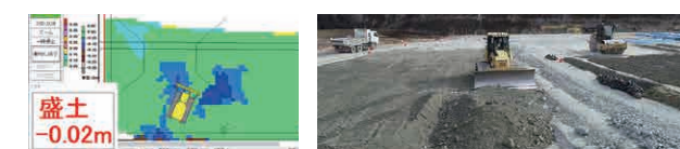
ブルドーザーのマシンガイダンスによる敷き均し
