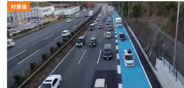
東名高速道路 横浜町田IC(下り線)の加速車線の延伸
