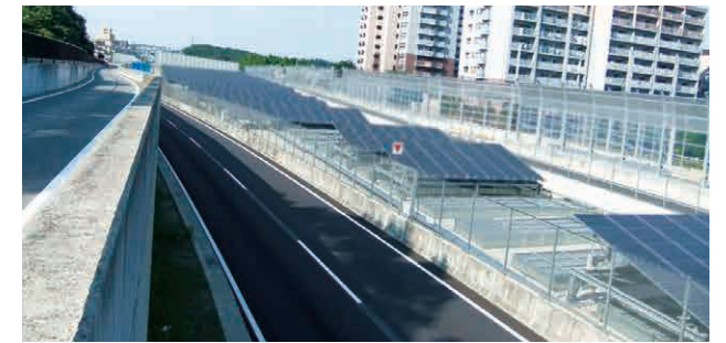
太陽光パネルの設置
