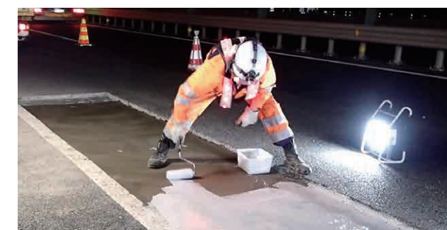
新たな床版防水技術で作業を行う風景
