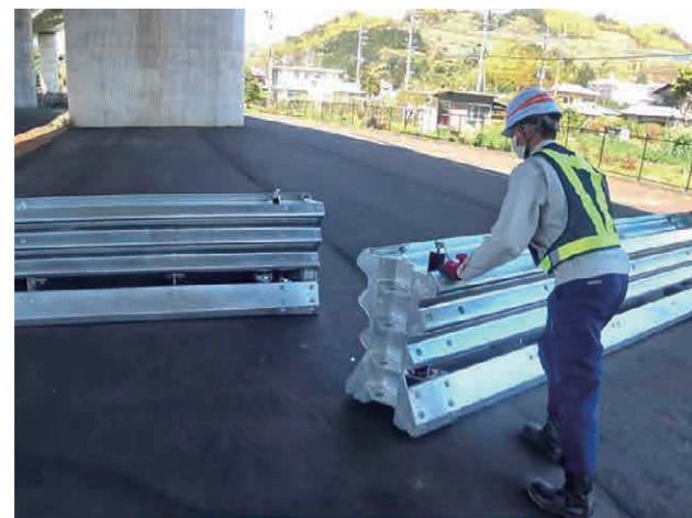
パルカンバリア(人力移動を可能にした鋼製仮設防護柵)
