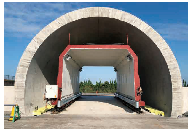
覆工機能を再生する施工方法
