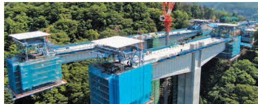
橋をつくっている様子
