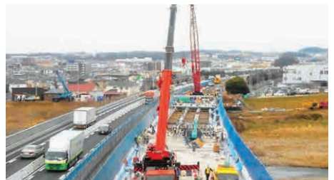
床版をかえている様子
