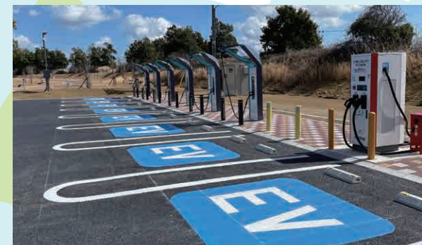
はまつサービスエリアに設置した 浜松SA(下り)に設置した 同時に何台も充電できるタイプ(写真左側)と 早く充電できるタイプの充電器(写真右側)
